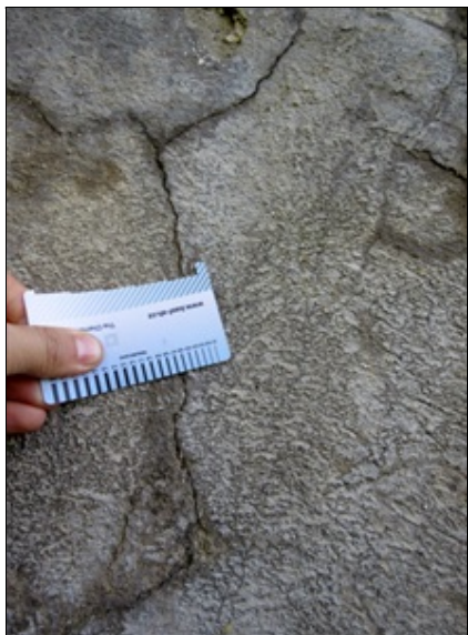
Na levém čele je ve vrcholu klenby otevřená vertikální trhlinka procházející až skrz římsu - detail v místě omítky klenby
