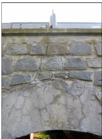
Na levém čele je ve vrcholu klenby otevřená vertikální trhlina procházející až skrz římsu
