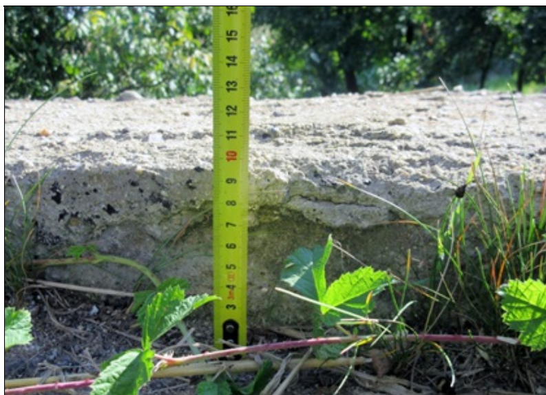
Obruby jsou nízké, výška nad vozovkou je 9cm
