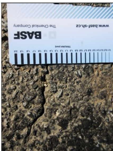
Trhlina ve vozovkovém krytu
