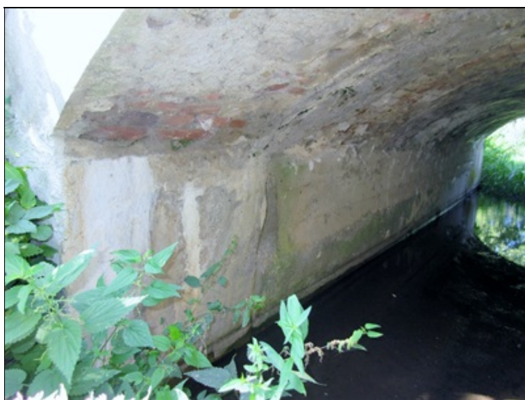
Opěra 1 zprava - přibližně metr od pravého okraje první opěry otevřená vertikální trhlina
