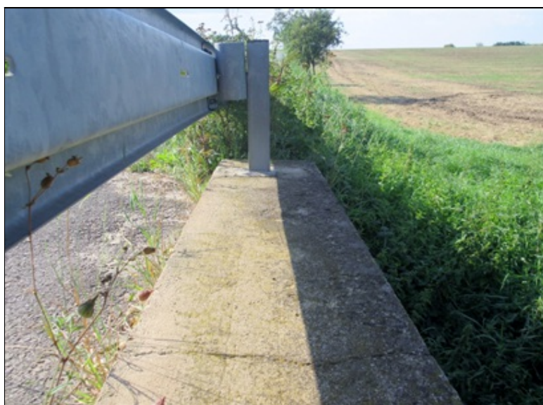
Levá římsa je opravována, v místě vrcholu klenby jsou trhliny
