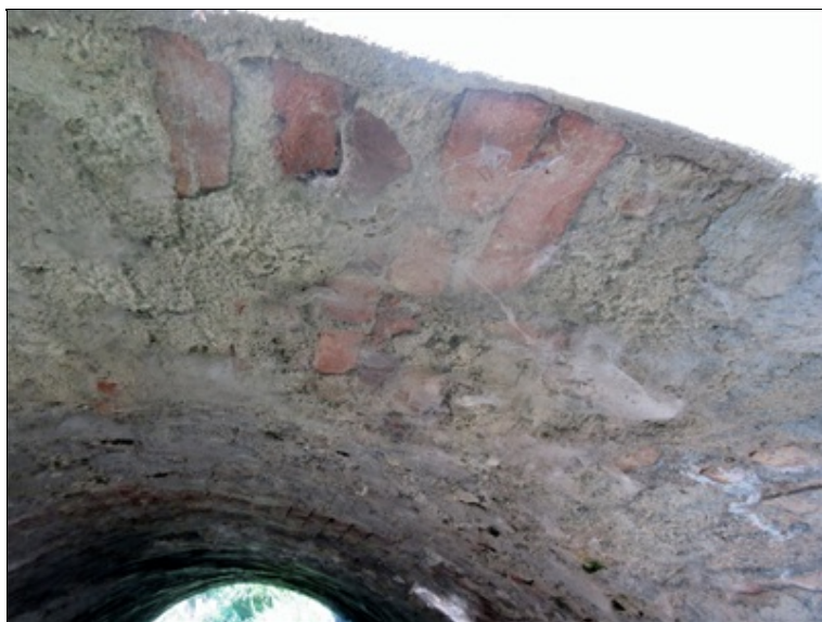
Podhled NK vpravo - torkret odpadává, odhalené cihelné zdivo
