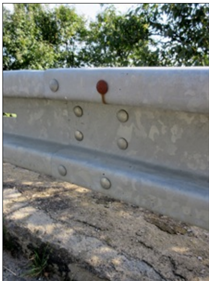
Spojovací prvky svodidla korodují
