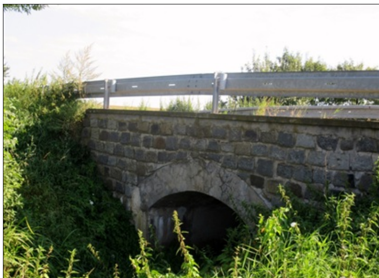
Na levém čele je ve vrcholu klenby otevřená vertikální trhlina procházející až skrz římsu
