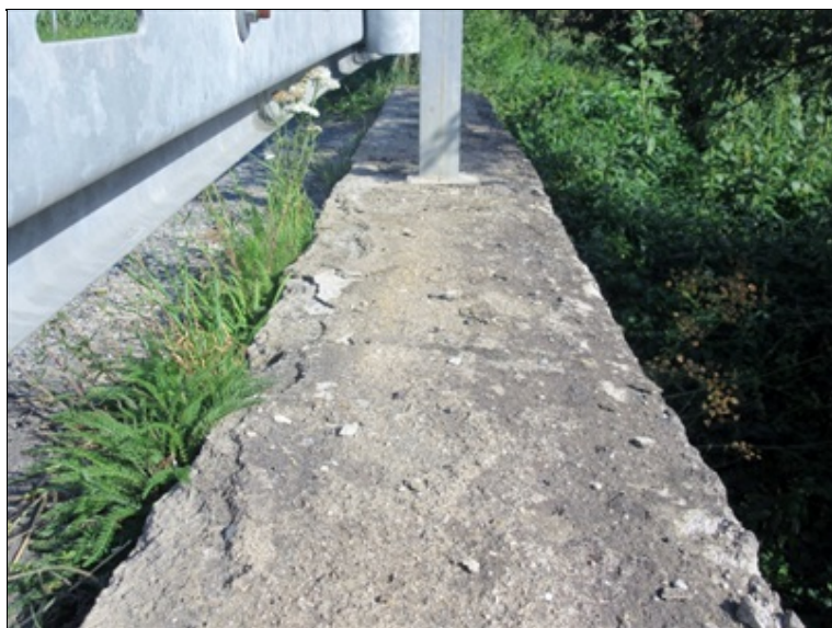
Povrch pravé římsy je hrubý, odmrzá a drolí se
