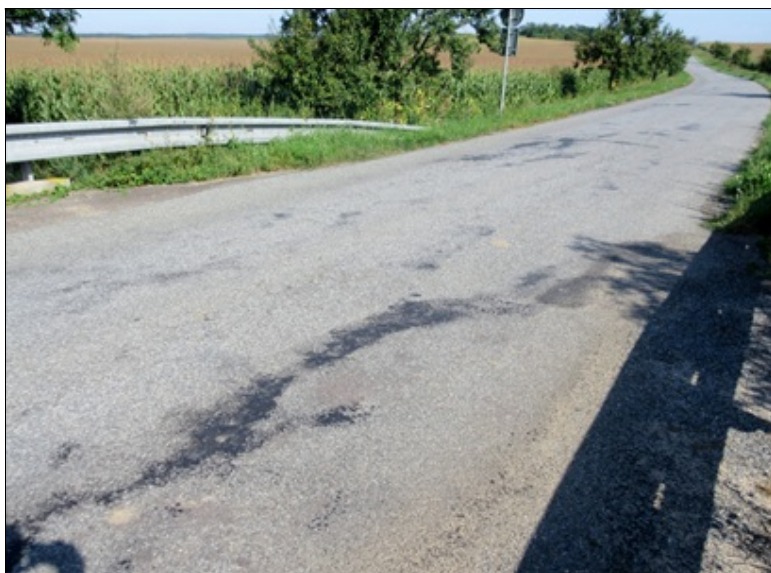
Trhlina ve vozovkovém krytu
